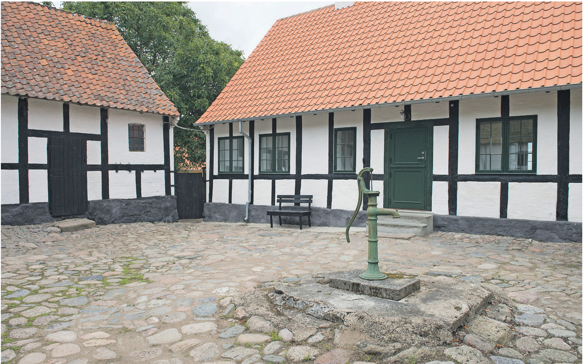
Listedgaard er renoveret med nyt tag og nye vinduer, men i respekt for de gamle bygninger. Gårdspladsen står stadig næsten som oprindeligt. Foto: Allan Rieck
